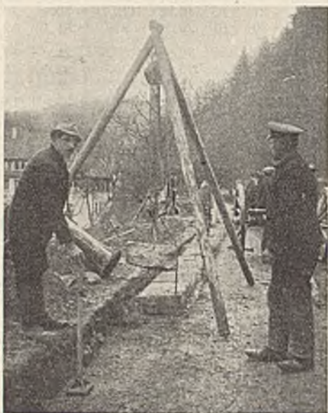
Abb. 1. Verlegen der Gleisbahn.
