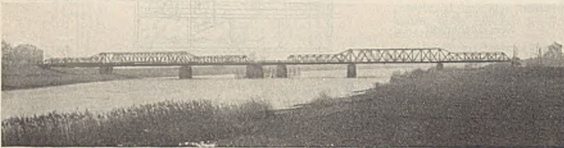
Abb. 10. Brückenbild nach der Inbetriebnahme.
