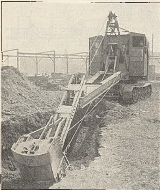
Abb. 13. Raupen-Grabenschaufel („ditcher“) von Link-Belt (Inhalt 0,75 m 3 ).
