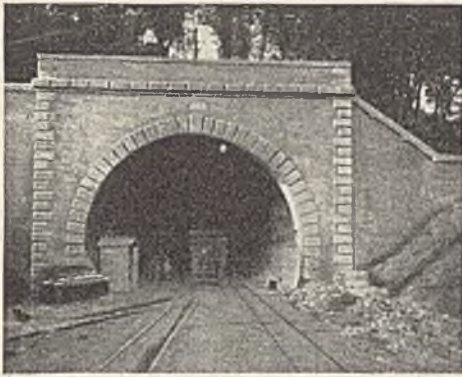
Abb. 1. Nordportal des Tunnels Monte Adone.
