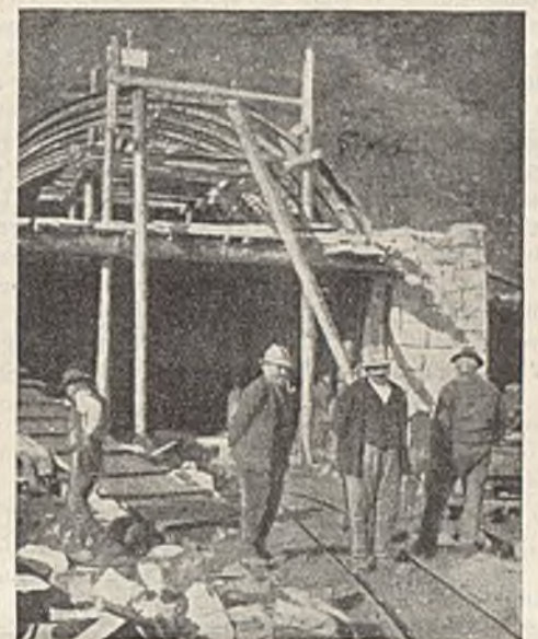
Abb. 4. Bau des Südportals des Tunnels Pian di Setta.
