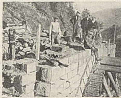
Abb. 5. Mauerung des Südportals des Tunnels Pian di Setta.
