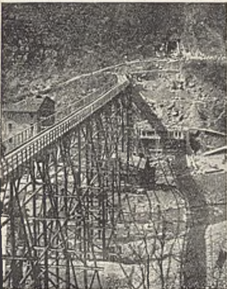
Abb. 2. Gerüstbrücke vor dem Südportal des Tunnels Pian di Setta.
