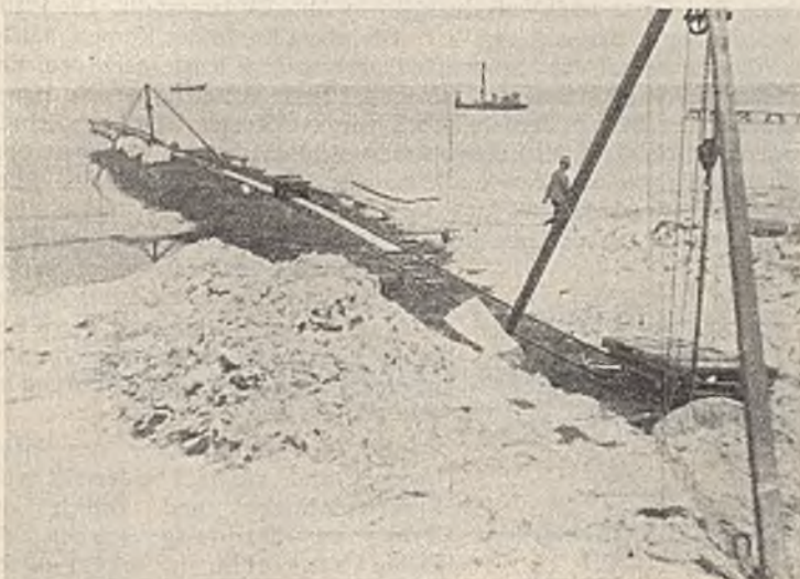
Abb. 34. Faschinenbuhnen auf Zingst. Herstellung des Landanschlusses.
