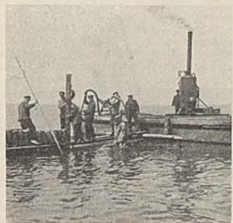
Abb. 59. Einspülen von Bühnenpfählen ohne Gerüst vom Floß aus.
