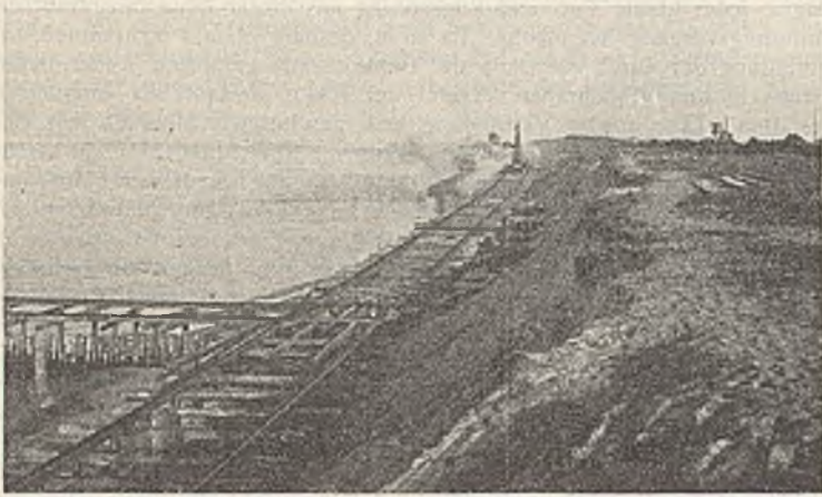
Abb. 26. Im Bau begriffenes Faschinendeckwerk am Ostende der Buhnengruppe bei Damkerort.
