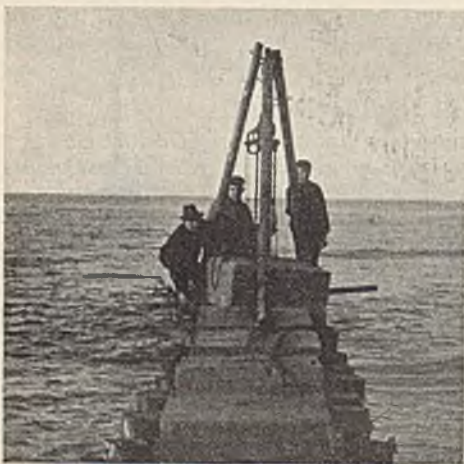
Abb. 62. Verlegen der Betonsteine mittels Dreibocks ohne Gerüst.
