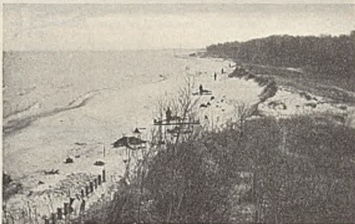
Abb. 17. Ufer vor Bauerhufen bei Beginn der Herstellung des Deckwerkes.
