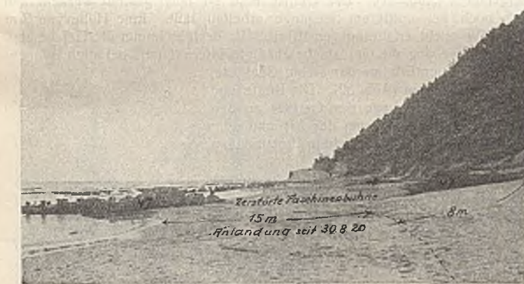
Abb. 43. Zerstörte Faschinenbühnen auf Land zwischen Streckelsbergmauer und Hotel Seeblick.
