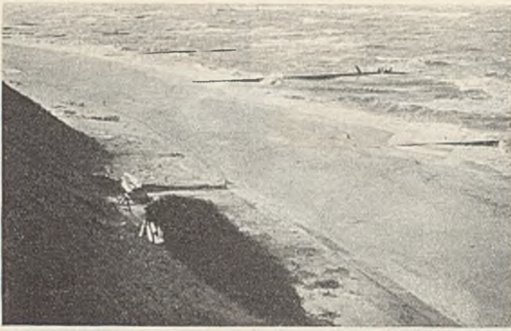
Abb. 16. Wirkung der Buhnenanlage vor Jershöft. Zustand vom Jahre 1926.
