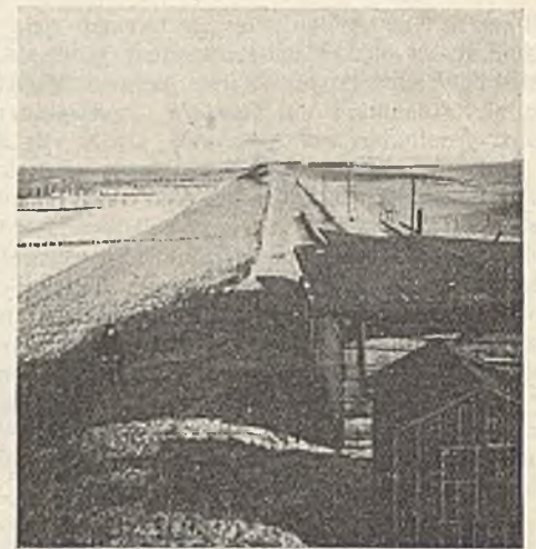
Abb. 11. Beginnende Einsandung des Pfahldammes bei der Uferschutzanlage von Damkerort.
