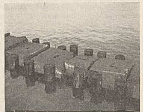
Abb. 46. Neueste zweireihige Bühne in Ostpommern. Abdeckung durch Betonsteine.
