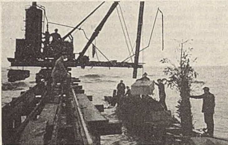
Abb. 61. Verlegen der Betonsteine mittels der Dampftramme.
