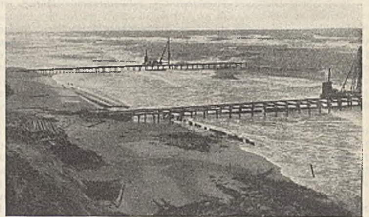
Abb. 51. Rammen der Bühnen vom Gerüst aus vor Jershöft.
