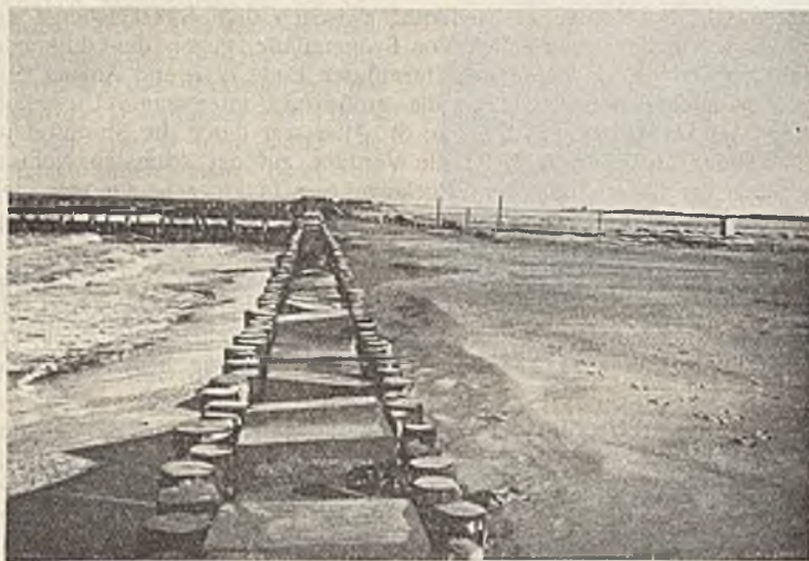
Abb. 9. Pfahldamm der Uferschutzanlage bei Damkerort.
