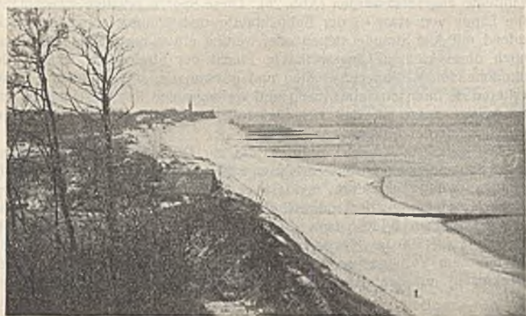
Abb. 24. Versandung der Buhnenlücke bei Bauerhufen (Blick nach Westen).
