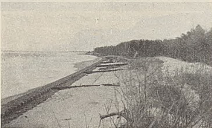
Abb. 18. Uferdeckwerk bei Bauerhufen nach den Stürmen im Winter 1926/27.
