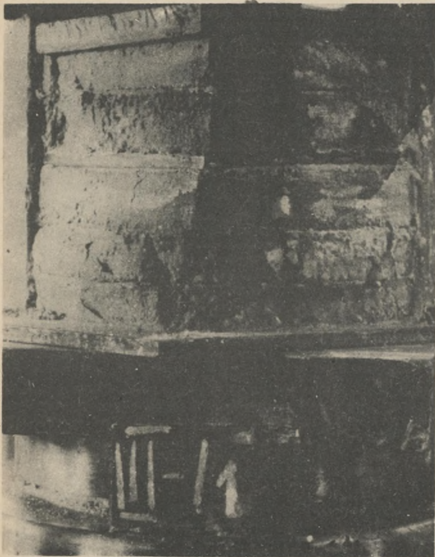
Rys.16. Początek deformacji warstw górotworu - przy dwóch płaszczyznach odsłoniętych dla układu warstw jak na rys. 14
