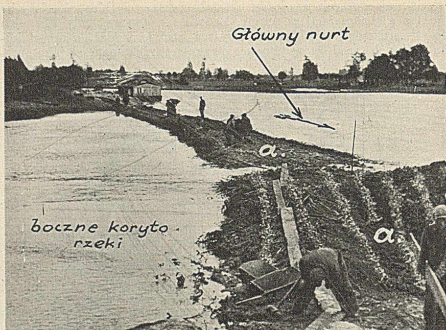
Ryc. 3. Budowa tamy faszynowej (a) tzw. przełamowania, zamykającego boczne koryto. Nurt rzeki przechodzi głównym łóżyskiem rzeki.
