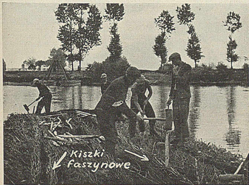
Ryc. 5. Przybijanie palikami kieszek faszynowych.
