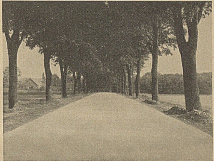
Abb. 3. Probestrecke in Solidititbeton auf der Provinziallandstraße Düsseldorf—Mülheim-Ruhr, km 15,5, Steigung 1:30, Juni 1925.
