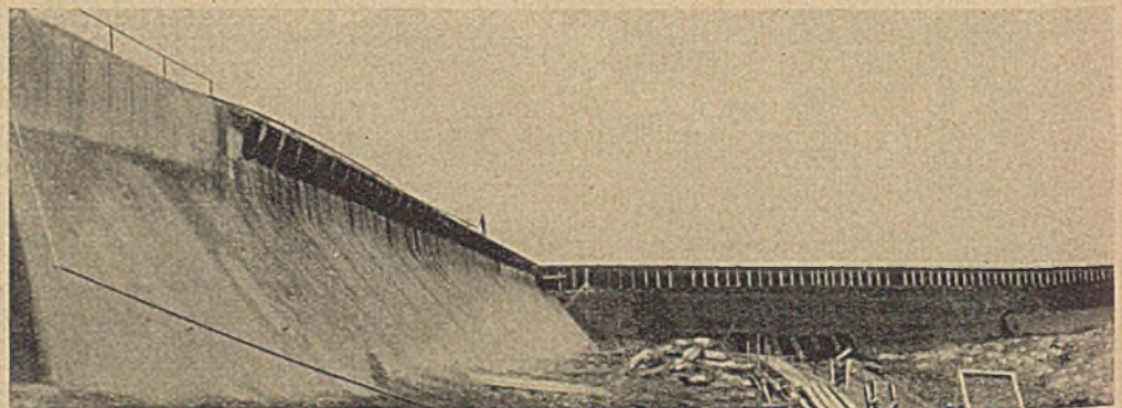
St. Croix River-Damm von der Unterwasserseite, der linke Teil bereits verkleidet.
