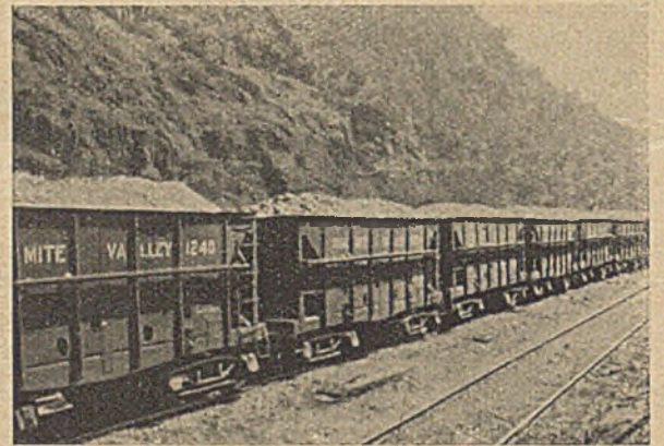
Abb. 1a. Anfuhr von ausgesiebttem Zuschlagsmaterial, Exchequer.
