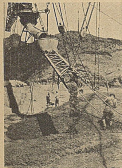
Abb. 2d. Gießen von Beton bei einer Schwergewichtsmauer bei Los Angeles 1925.
