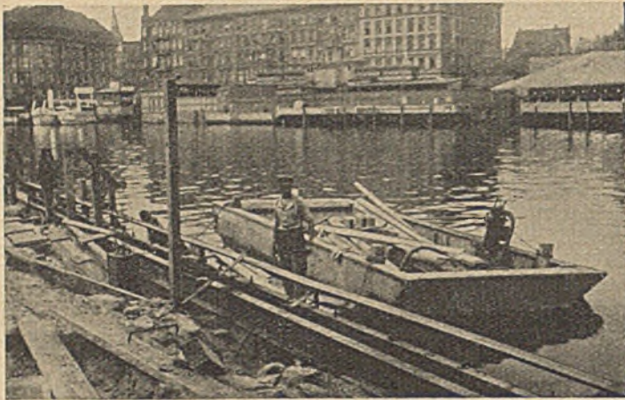
Abb. 5. Die Larssenwandstrecke nach dem Einhängen der Platten von der Landseite.
