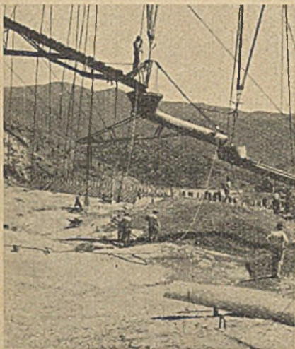
Abb. 2c. Gußbetonanlage (Sperrreife bei Los Angeles).
