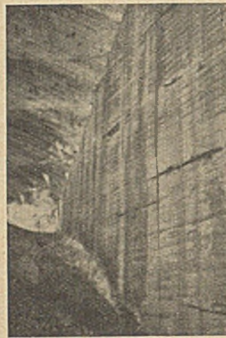
Abb. 10 b. Pfeiler bei einer Eisenbetontalsperre.
