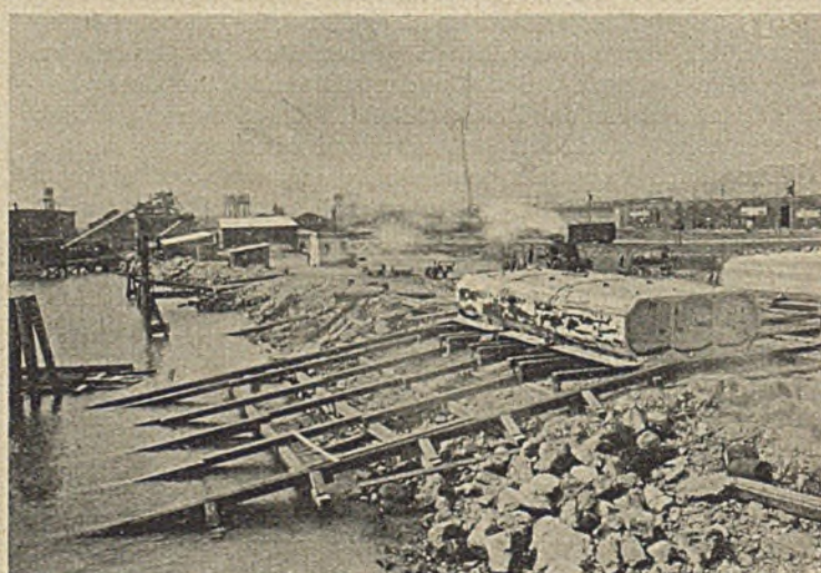
Abb. 13 d. Caisson zum Einbringen bereit.
