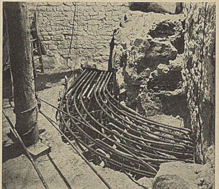
Abb. 13. Eiseneinlagen für den unteren Fundamentring.
