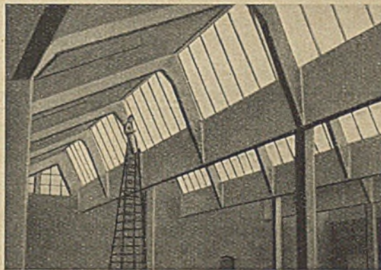
Abb. 1b. Blick in das fertige Innere.
