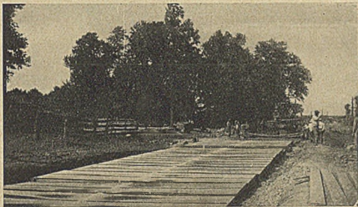
Abb. 24 c. Nacherhärtung von Betonstraßen unter Bretterschutz.
