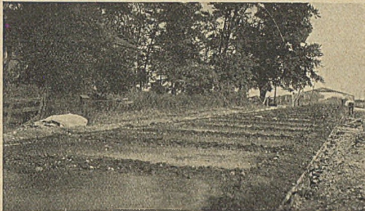
Abb. 24 b. Erhärtung von Betonstraßen unter Wasser.
