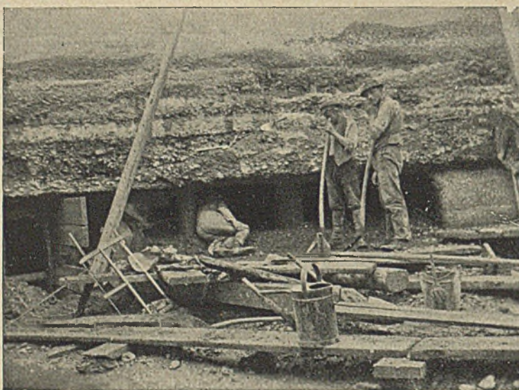
Abb. 5. Sicherung hohlgelegender Grundmauern des Fischpasses.
