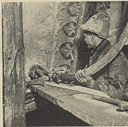
Abb. 17. Einpressen von Zementmörtel (Injektion).
