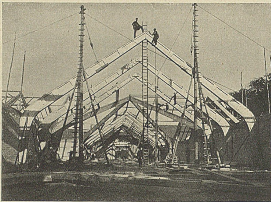
Abb. 8. Innenaufnahme der Halle während des Baues.
