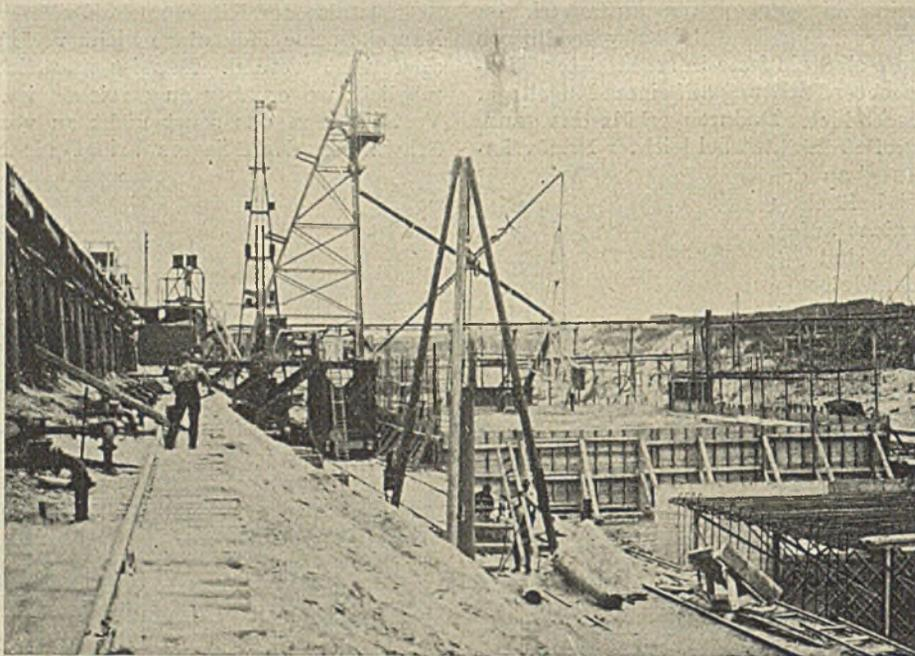
Abb. 6. Betonierung des Sohlenblocks 1, Anlage des Südstrangs der 2. Staffel.
