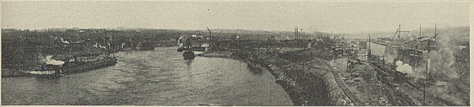
Ansicht der Gesamthauustelle der Kachletstufe an der Donau. Bauzustand Ende 1924.
