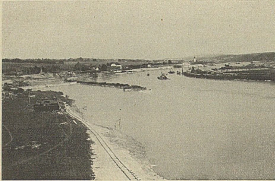
Abb. 2. Die Baustelle der Kachletstufe von Unterstrom gesehen.
