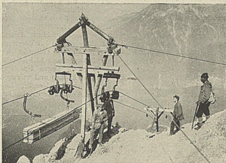
Abb. 6. Hilfsseilbahn für Personen- und Lastentransport.
