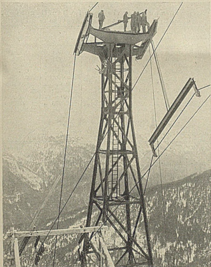
Abb. 7. Auflegen der Tragsseile auf eine Stütze.
