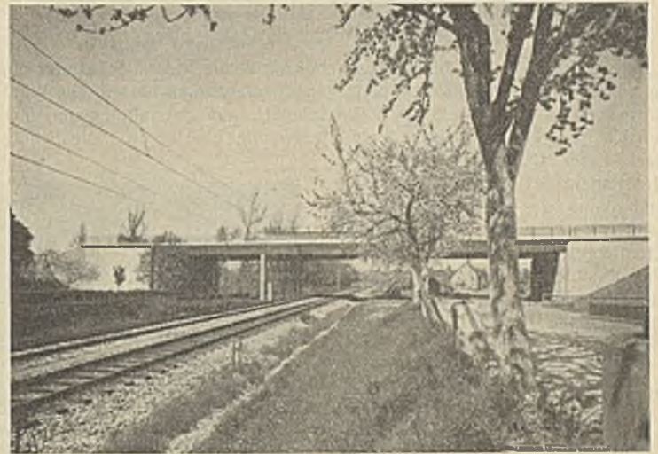
Abb. 9. Die fertige Unterführung.
