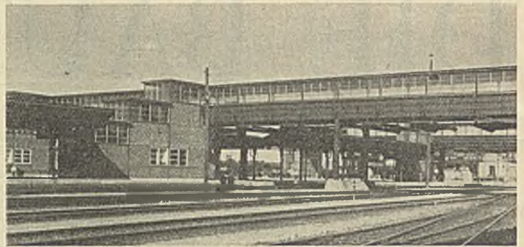
Abb. 5. Personenbrücke auf Bahnhof Glogau.
