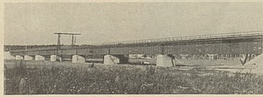
Abb. 3. Warthehlutbrücke bei Schwerin.
