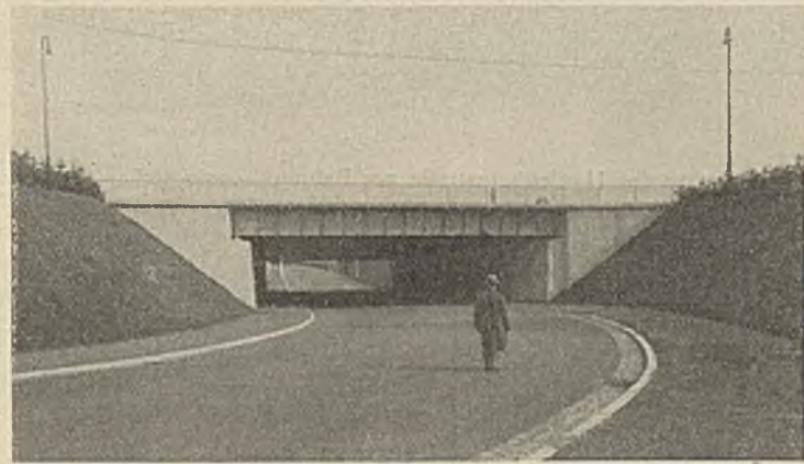
Abb. 1. Unterführung unter dem Bahnhof Nürnberg-Dutzendteich.
