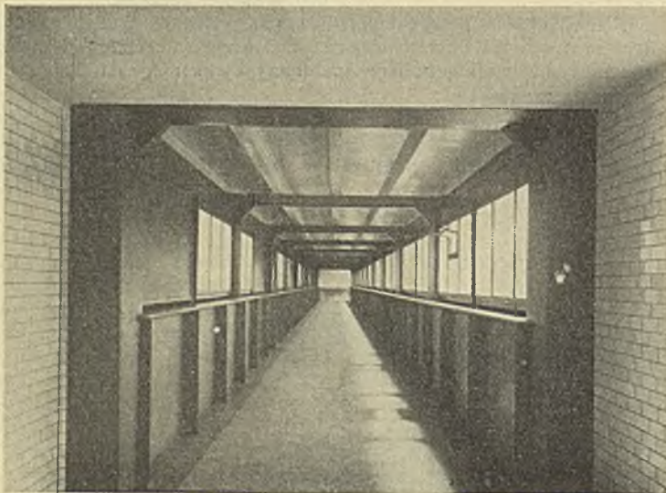
Abb. 6. Fußgängerbrücke auf Bahnhof Küstrin-Neustadt.
