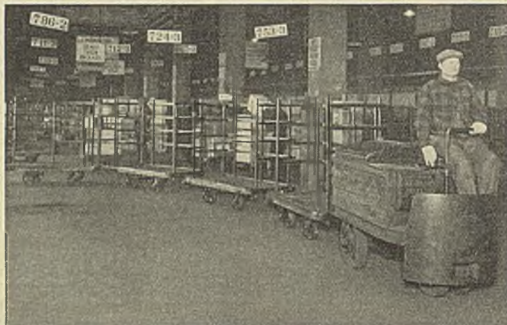
Abb. 12. Handkarren, zu schienenlosen Zügen zusammengestellt, zur Förderung von Kaffeesäcken usw. in den Kaischuppen des neuen Hafens von Cartagena.
