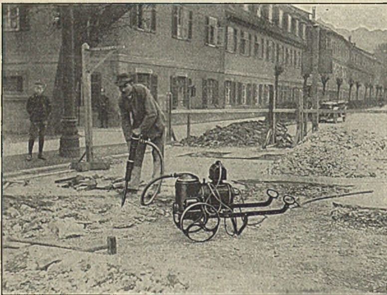
Abb. 1. Betonlosbrechen.
