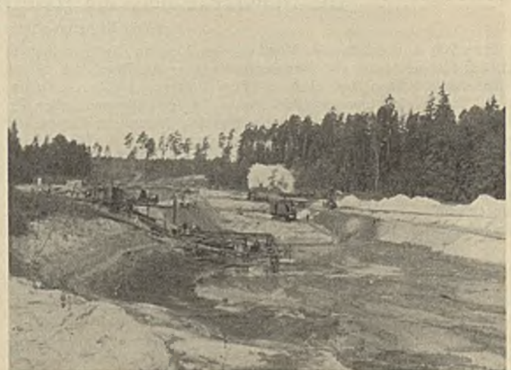
Abb. 7. Masurischer Kanal. Ausräumen von Faulschlamm.
