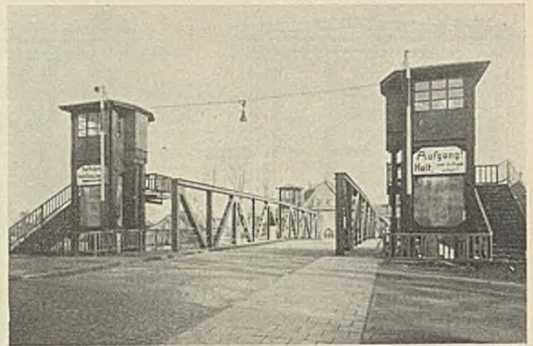
Abb. 9. Längsblick über die Brücke.
