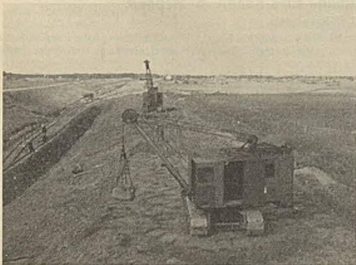
Abb. 6. Masurischer Kanal. Stampfen der Dämme.
