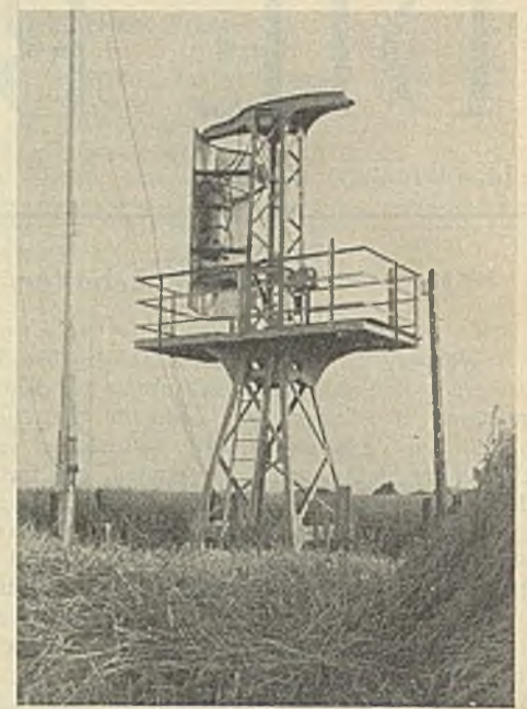
Abb. 3. Luftschallsender in Dahmeshöved. Ansicht von hinten.
