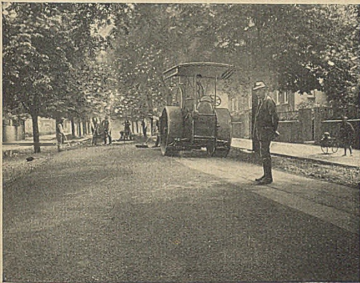
Abb. 4. Kalteinbau und Walzen von „Termak“.
