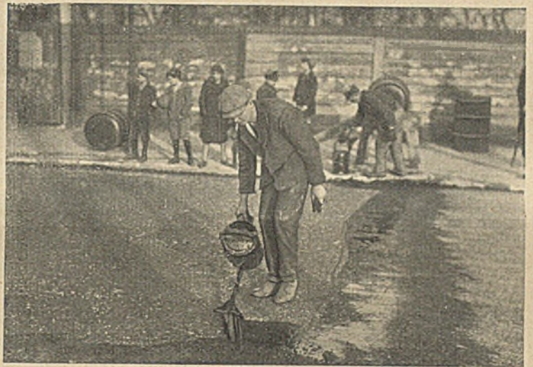
Abb. 5. Aufgießen der Asphalt emulsion.
