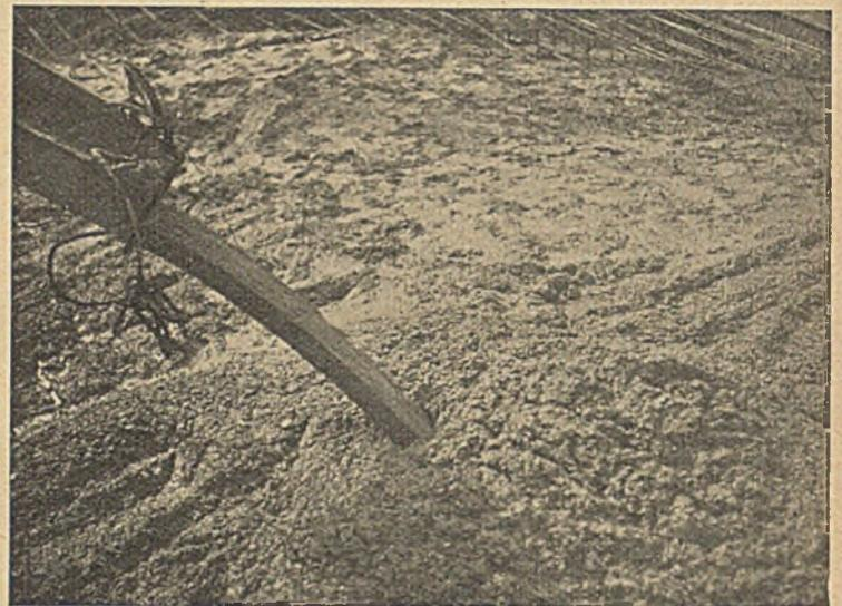
Abb. 12. Gußbeton mit geringstmöglichem Wasserzusatz.
