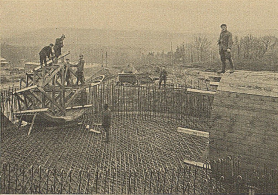
Abb. 14. Eisenbewehrung des Wasserschloßfundamentes.
