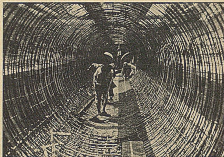
Abb. 5. Bewehrung des Druckrohrs.
