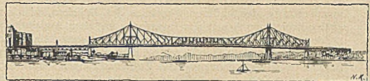
Abb. 6. Die Auslegerbrücke. Canadian Bridge Co., Canada.
