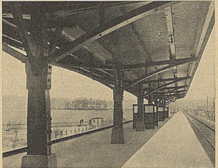
Abb. 9. Ansicht des Bahnsteigdaches in Zwickau-Pölbitz.
