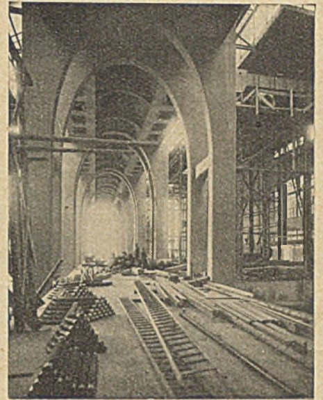
Abb. 4. Großkraftwerk Golpa-Zschornowitz. Erweiterungsanlagen 1926. Eisenbeton-Kohlenbunker, von der Schürraumdecke aus gesehen.
