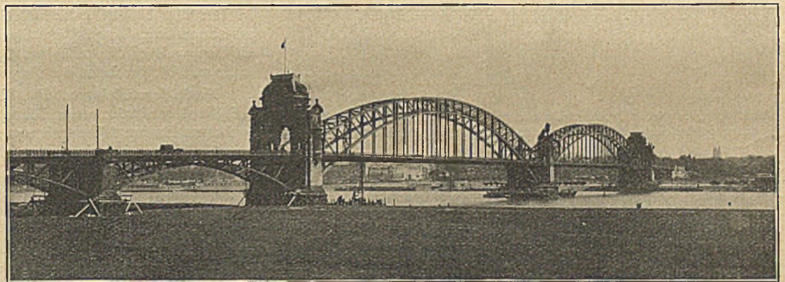
Abb. 3. Gesamtansicht der Brücke vor dem Umbau.
