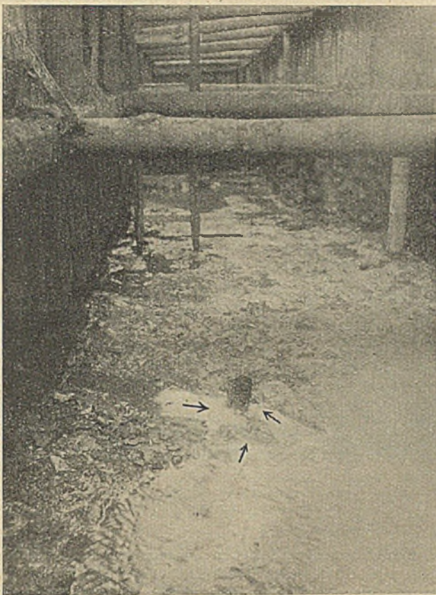
Abb. 1. Fundamentsohle des Brückenpfeilers II.
