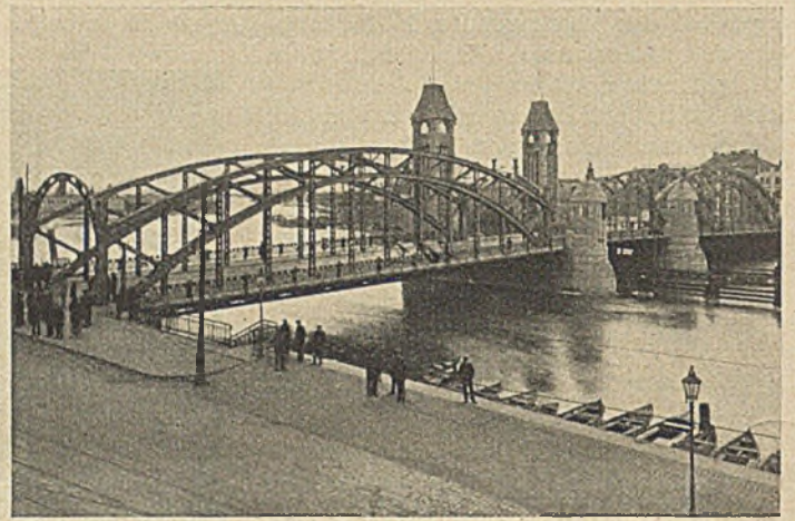
Abb. 4. Straßenbrücke (Baumbrücke) über die Oder in Stettin.
