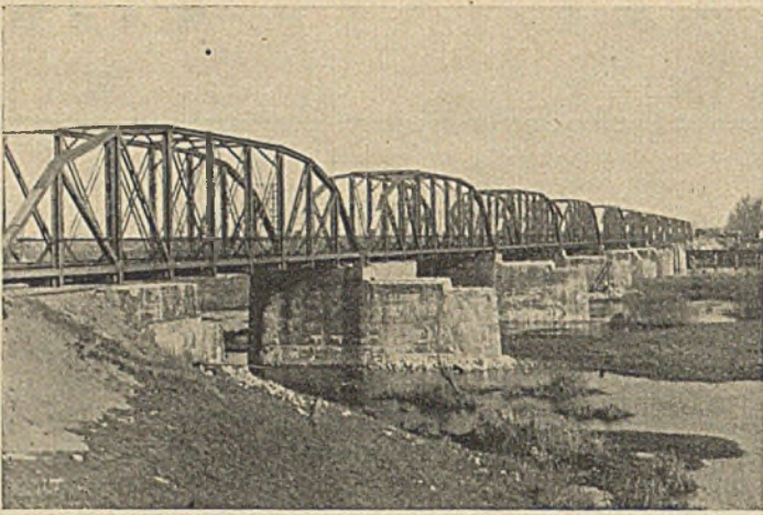
Abb. 1. Eisenbahnbrücke (alte) über die Oder bei Deutsch-Nettkow.
