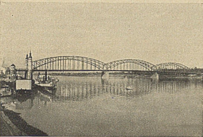
Abb. 9. Straßenbrücke über die Memel bei Tilsit (Königin-Luise-Brücke).
