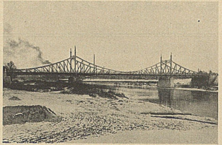
Abb. 2. Straßenbrücke über die Oder bei Ratibor.
