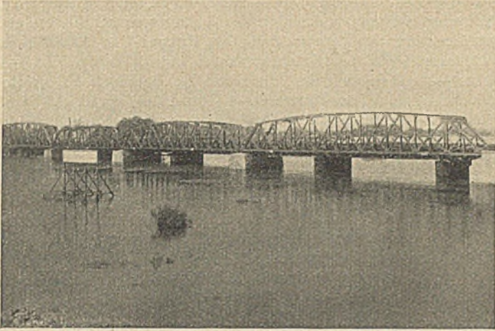
Abb. 7. Eisenbahnbrücke über die Oder bei Cüstrin.
