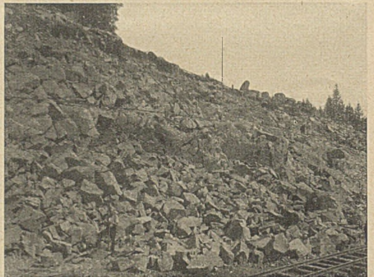
Steinbruchwand nach dem Sprengluftbeschuß.
