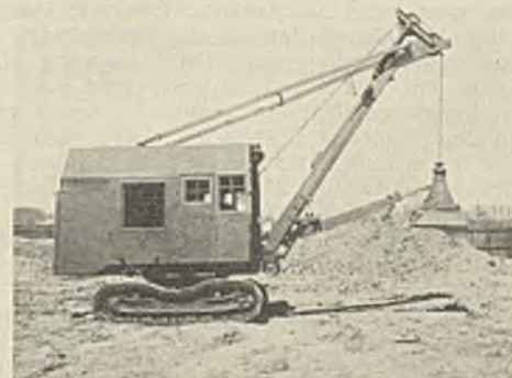
Abb. 1. Umbaubagger als Stampfgerät mit selbsttätiger Steuerung der Stampfplatte.
