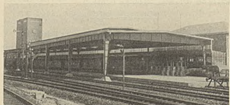
Abb. 31. Postbahnsteigehalle auf Bahnhof Oberhausen.
