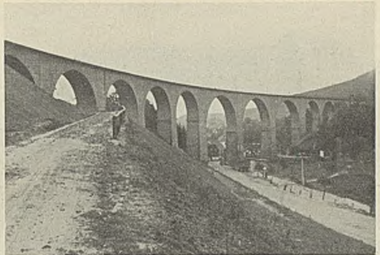
Abb. 28. Talbrücke bei Oberkirchen.
