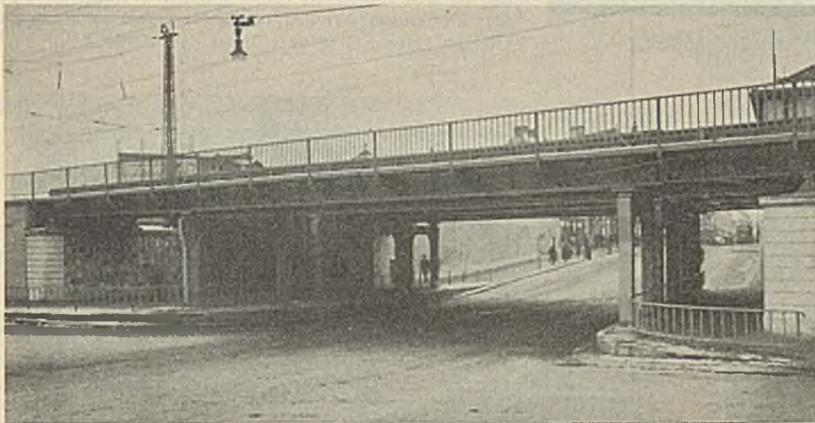
Abb. 25. Unterführung der Salzer Straße in Schönebeck.
