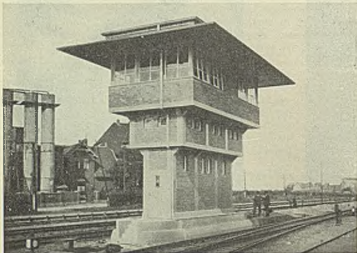
Abb. 32. Stellwerk auf Bahnhof Rethen.
