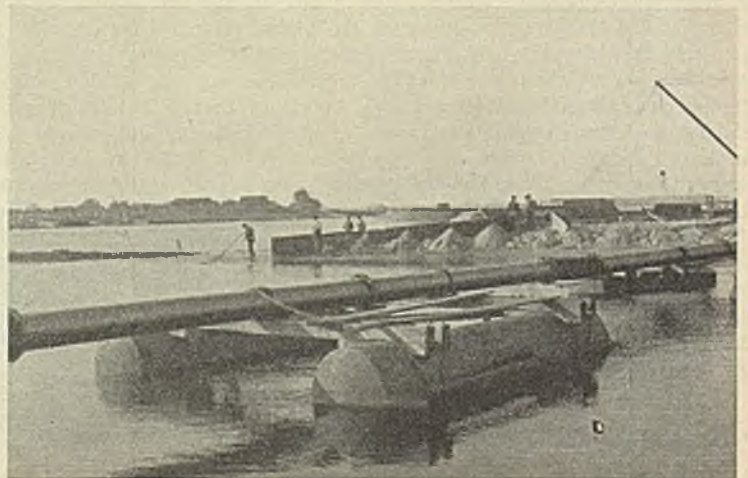
Abb. 31. Elbeausbau bei Bleckede. Herstellung eines Bühnenkörpers im Spülverfahren.
