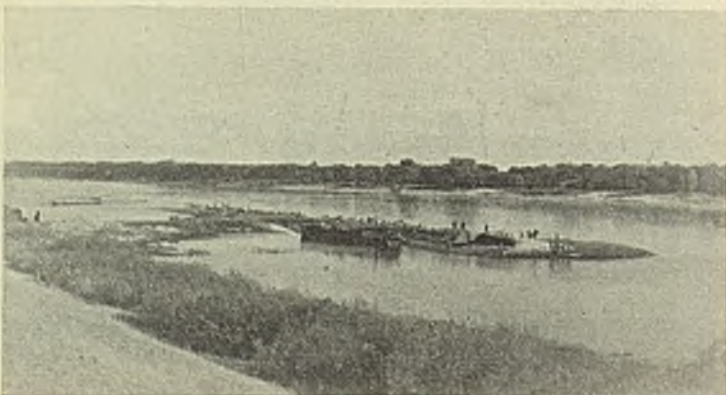
Abb. 30. Elbeausbau bei Vietze—Kl. Wootz. Hammerbühne im Bau.
