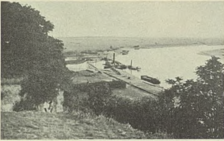
Abb. 28. Elbeausbau bei Lostau (Überblick).
