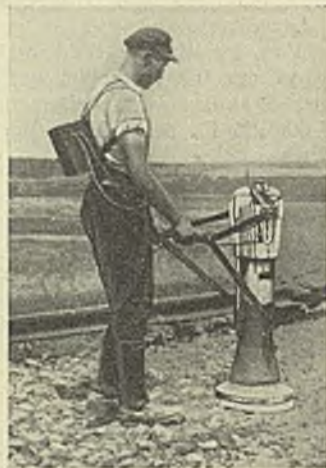
Abb. 1. Explosionsstamper zum Verdichten von Gleißbettungen.
