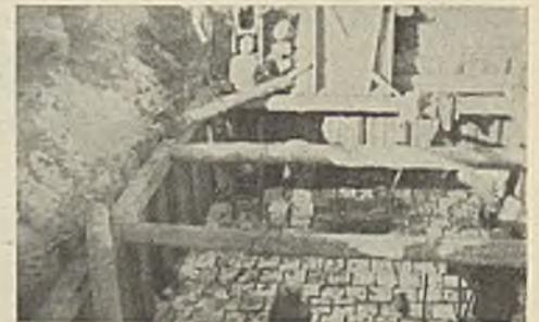
Abb. 5. Pfeilerbaugrube.
