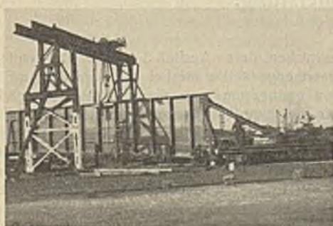
Abb. 13. Befördern der Stahlträger.
