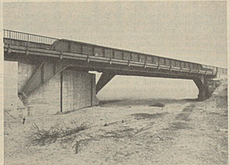
Abb. 12. Ansicht der Vollwandrahmenbrücke.
