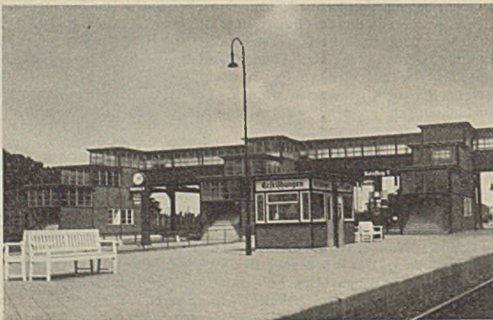
Abb. 6. Nordende der Brücke mit den Bahnsteigtrepfen.
