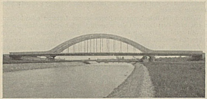
Abb. 1. Kinzigbrücke bei Kehl. (Ausführung Züblin & Cie. AG, Kehl a. Rhein.)
