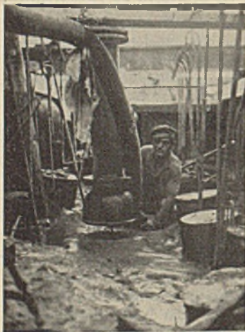
Abb. 10. Abpumpen der Pfeilerbaugruben.
