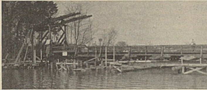
Abb. 1. Die alte Brücke.
