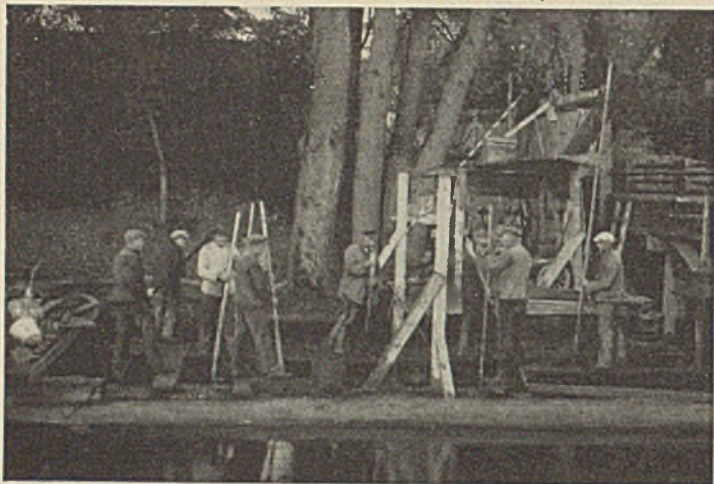
Abb. 9. Aushub in Pfeiler I mit Sack- und Baggerschaufeln.
