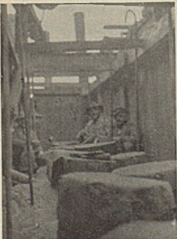
Abb. 11. Sicherung der Pfähle gegen aufsteigendes Wasser.
