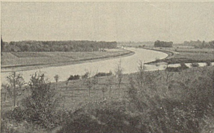
Abb. 44. Saale-Durchstich bei Kreypau. Rechts alter Saalelauf.
