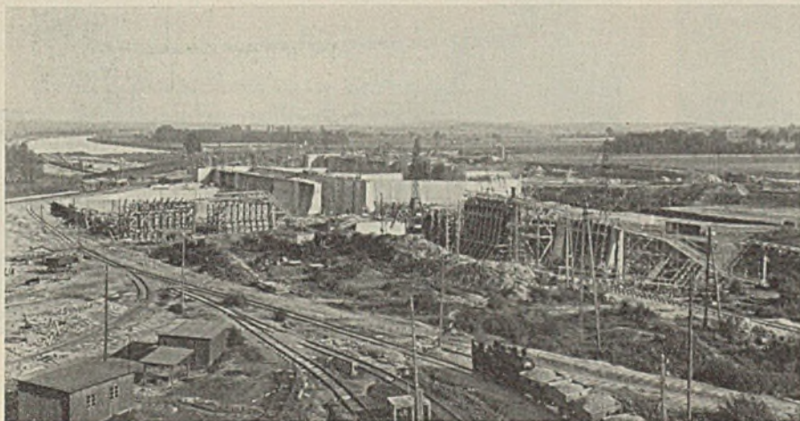
Abb. 33. Gesamtansicht der Schleusenbaustelle Allerbüttel-Sülfeld (Oktober 1935).
