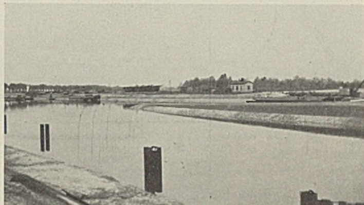
Abb. 32. Oberer Vorhafen der Schleusen Allerbüttel-Sülfeld mit Umschlagstellen.
