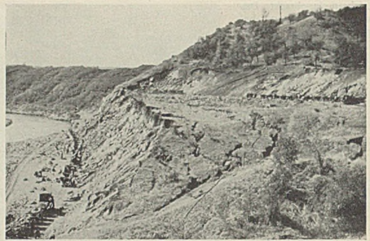
Abb. 47. Oberer Schleusenkanal bei Rothenburg. Abtrag der Rutschfläche.
