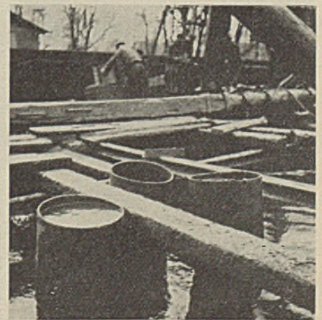
Abb. 14. Die fertig gebohrten Pfähle.
