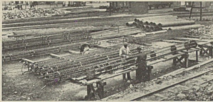
Abb. 9. Herstellung der Bewehrung.
