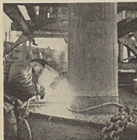
Abb. 13. Aufeinanderschweißen der Rohre.
