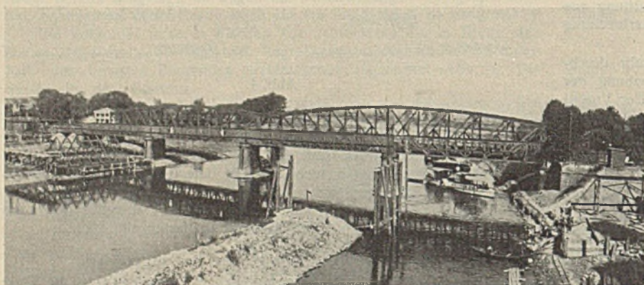
Abb. 12. Ansicht der alten Brücken.
