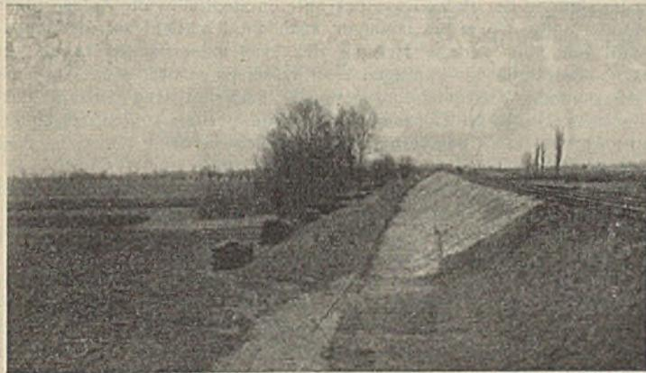
Abb. 7. Alter Damm nach Abhub des Rasens und Auskoffert am Fuße des neuen Damms.
