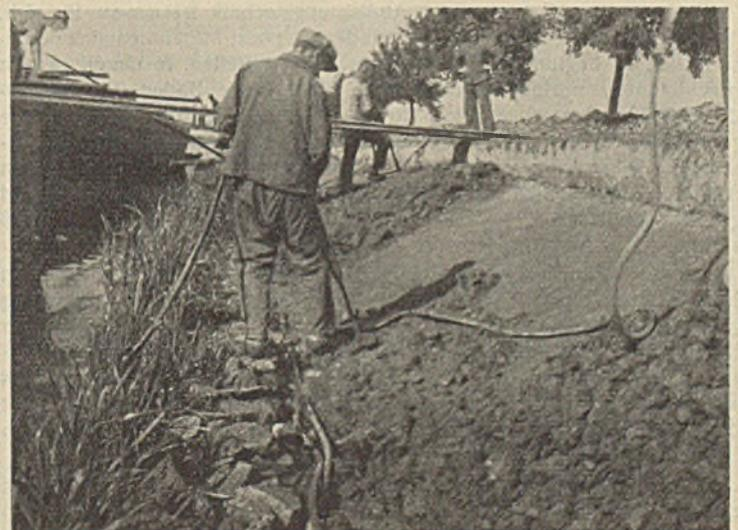
Abb. 59. Hebung des Wasserspiegels im Ems-Weser-Kanal. Feststampfen der hochgeführten Tondichtung.
