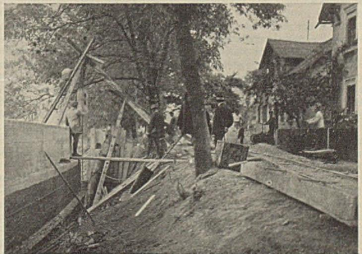
Abb. 10. Rammen der Eisenblechhülsen für die Eisenbeton-Konuspfähle. Die Schlagzeuge werden mit Benzinwinden betrieben.
