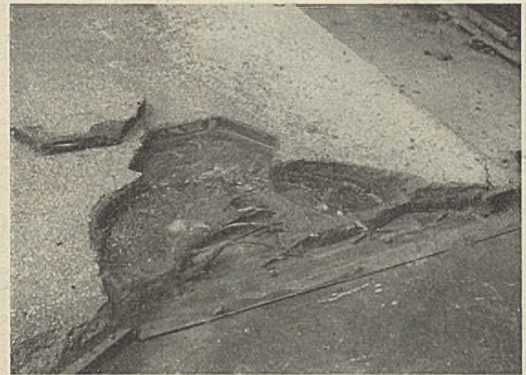
Abb. 17. IG-Belag mit Quarz splitt auf Stampfasphaltplatten.
