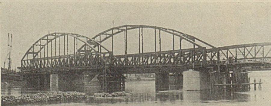
Abb. 25. Verschieben des zweiten großen Überbaues.
