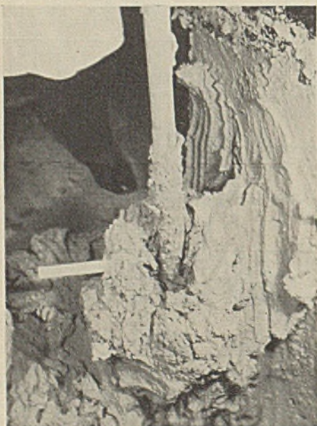
Abb. 8. Ausbau eines Pfahles nach Beendigung des Versuches.
