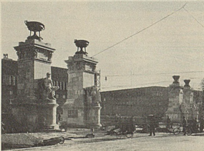
Abb. 12. Die nunmehrige Aufstellung der Pylonen am Kopfe der neuen inneren Ludwigsbrücke.
