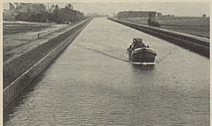
Abb. 65. Erweiterung des Dortmund-Ems-Kanals mit Uferspundwand auf beiden Seiten.
