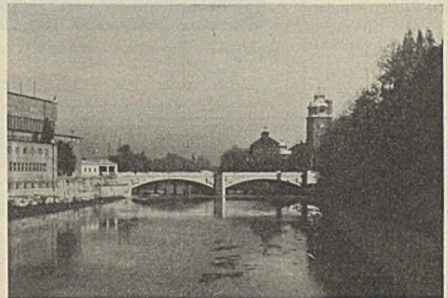
Abb. 13. Südansicht der äußeren Ludwigsbrücke.
