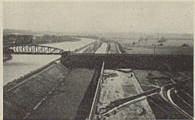
Abb. 63. Erweiterung des Dortmund-Ems-Kanals bei km 7,2 mit Zechenbrücken Minister Achenbach.
