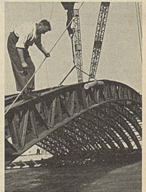
Abb. 5. Innere Ludwigsbrücke. Eisenkonstruktion.
