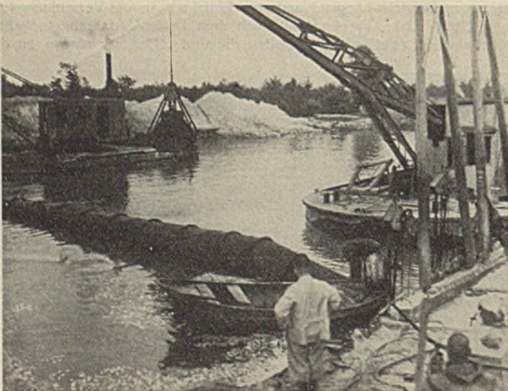
Abb. 69. Heben eines alten Dükerrohres.
