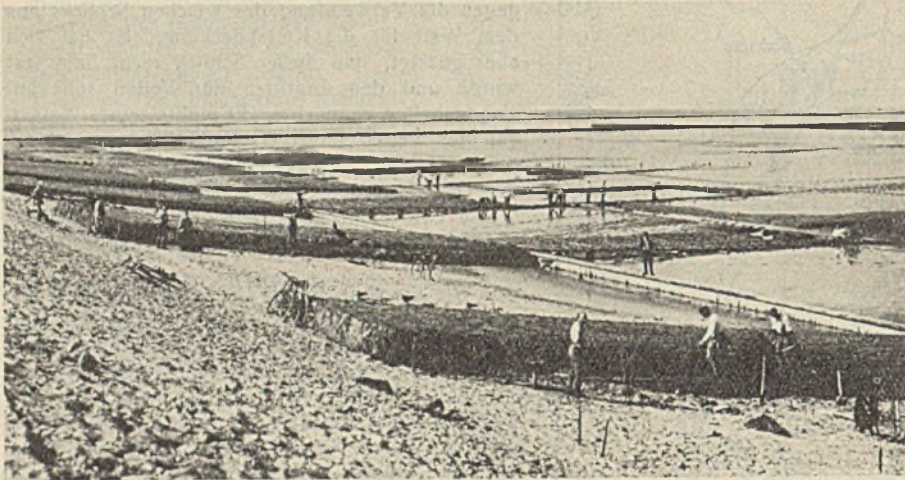
Abb. 8. Abdeckung der Dammböschungen mit Kleiboden.
