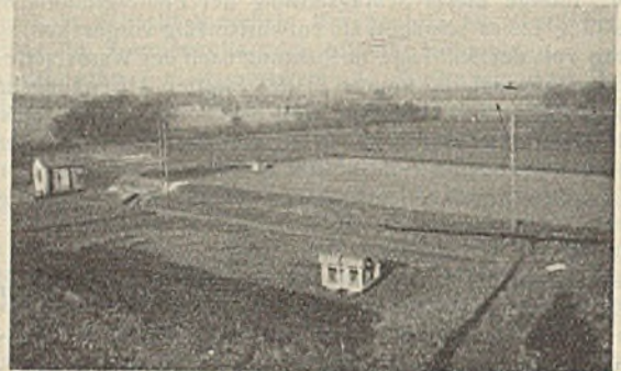
Abb. 7. Erdbecken als zweistufige Schlammfau Räume in Reading.
