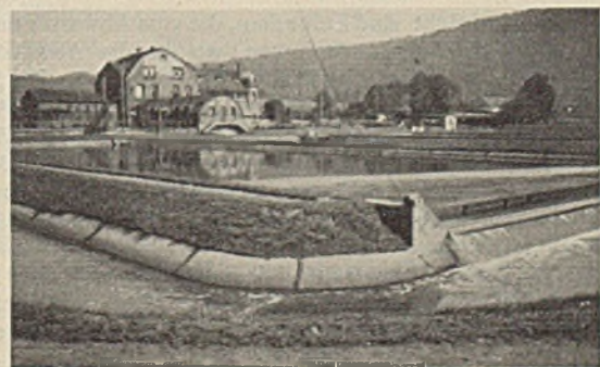
Abb. 4. Befestigte, flache Absetzbecken mit Handausräumung in Wuppertal.
