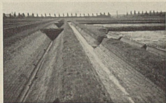
Abb. 3. Eine der ersten Sickerbeckenanlagen für gemischtes häusliches und gewerbliches Abwasser des Ölbachs bei Witten. Rechts die Becken, links der Entwässerungsgraben für die verschließbaren Sickerrohre.
