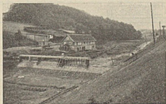
Abb. 12. Abwasserteich des Wupperverbandes in Lennep während des Baues.
