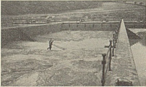
Abb. 5. Handausräumung des Schlammes in tiefen Absetzbecken einer englischen Anlage (Bradford).
