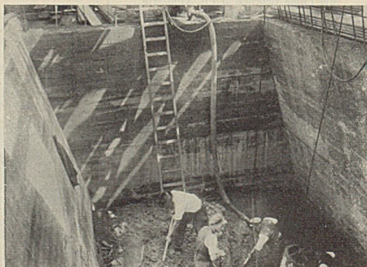
Abb. 6. Bodenaushub im Ringraum.
