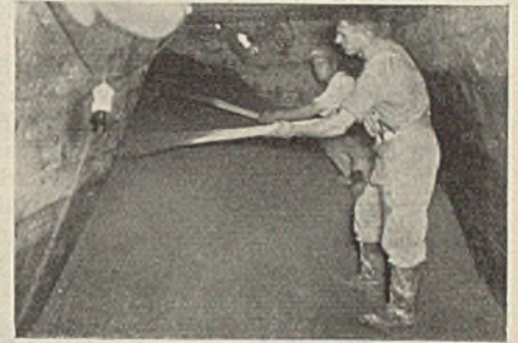
Abb. 7. Ausbetonieren des Arbeitsraumes.
