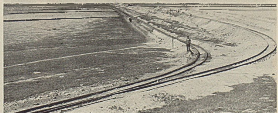
Abb. 7. Überblick über die Dammbaustelle vom Festlande aus (Juli 1934).
