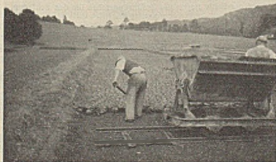
Abb. 2. Schlamm-trockenplatz der neuen Kläranlage in Wuppertal.
