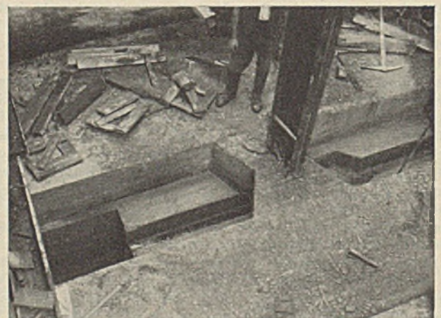
Abb. 5. Einbau der Dichtung der Dehnungsfugen.
