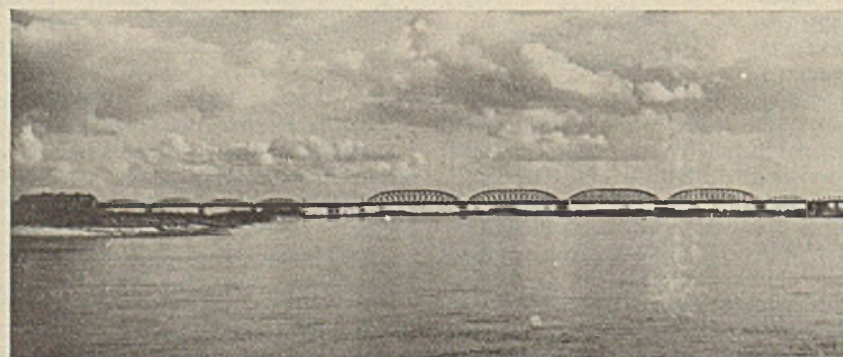
Abb. 15c. Die 1872 bei Dömitz erbaute Eisenbahnbrücke.
