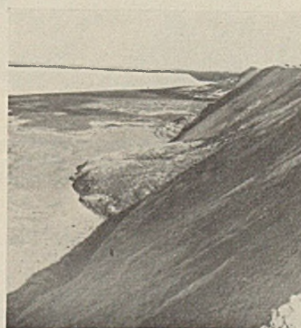
Abb. 37. Kippenausbruch auf „Brigitte“ AG.
