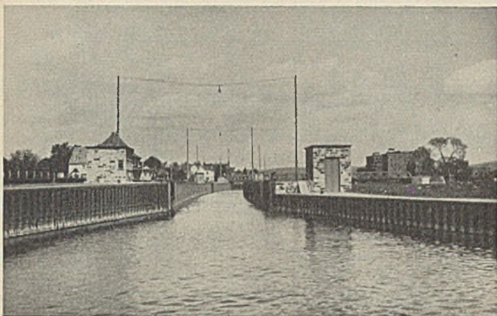
Abb. 6. Schleuseneinfahrt vom Oberwasser.
