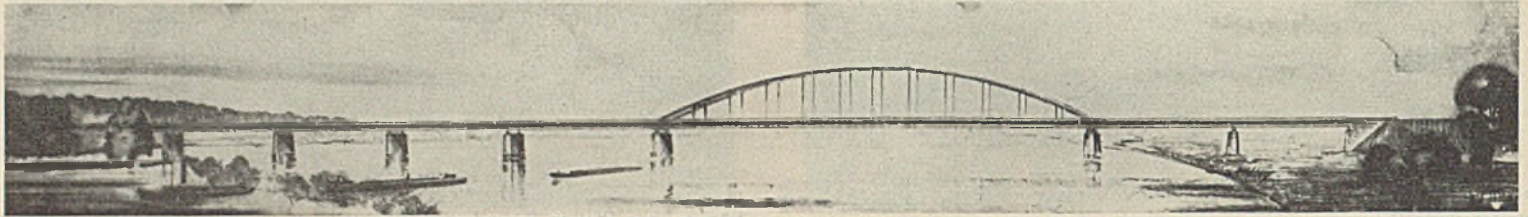
Abb. 53b. Schaubild der ausgeführten Stabbogenbrücke.
