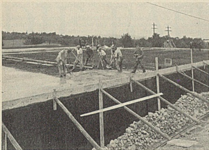
Abb. 6. Behälter Kuhberg. Betonierung der Decke.
