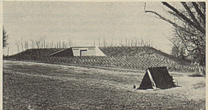
Abb. 7. Behälter Kuhberg. Ansicht und Schieberkammer.
