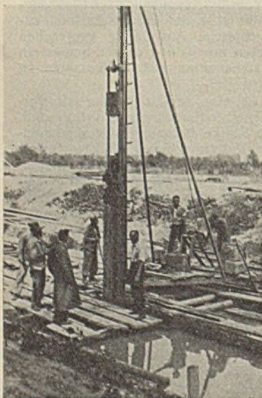
Abb. 1. 300 kg-Dieselramme der Delmag beim Rammen von Larssen-Spundwänden.
