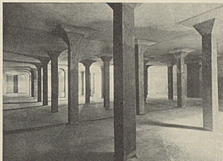
Abb. 8. Behälter Kuhberg. Innenansicht.
