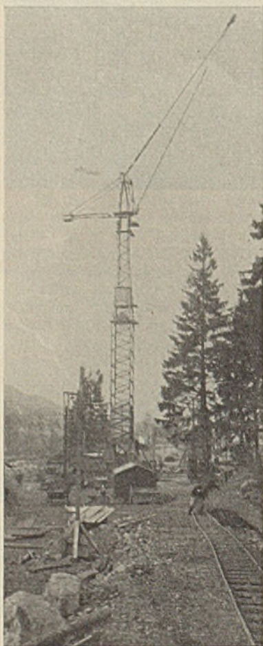
Abb. 2. Ansicht des fertig aufgestellten Kranes.
