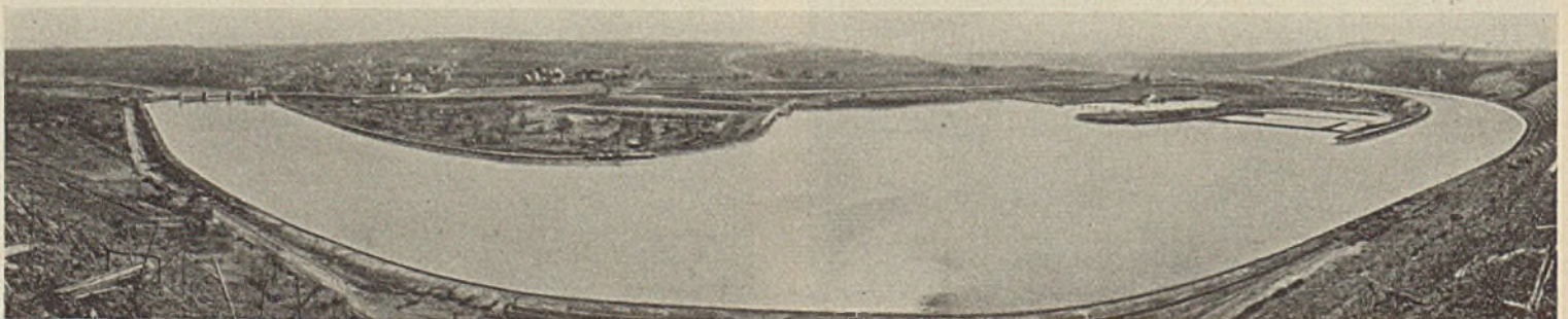
Abb. 85. Staustufe Münster, II. Bautell. Reguliertes Neckarbett mit Wassersportsee bei Hofen, links Wehr und Kraftwerk.
